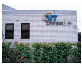
設備の増設をし市全域への情報発信に向け幹線伝送路を光ファイバー網へ布設替えの同舎
