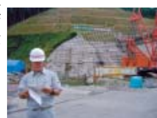
大内町ダム工事現場 年度内完成
